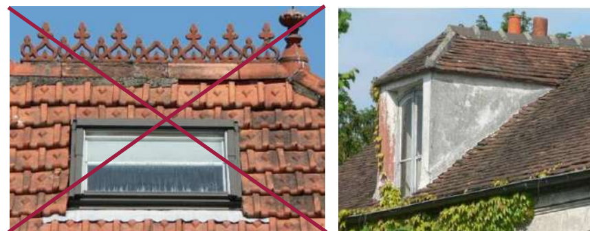
Exemples d'ouvertures assurant l'éclairage des combles
