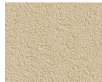
Enduit à la chaux
