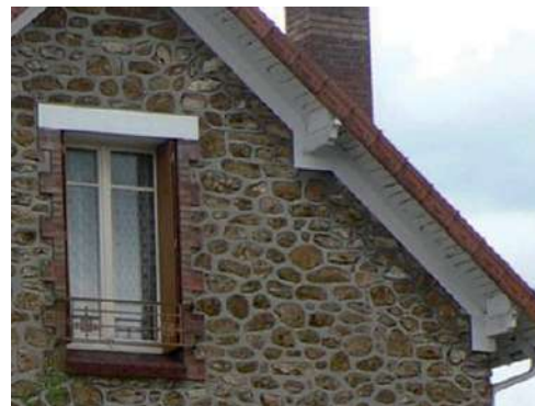
Exemple de façade en pierres meulières
