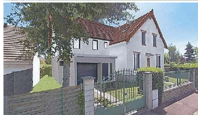
Exemples de constructions neuves
