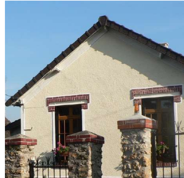
Exemple de couleur de façade
