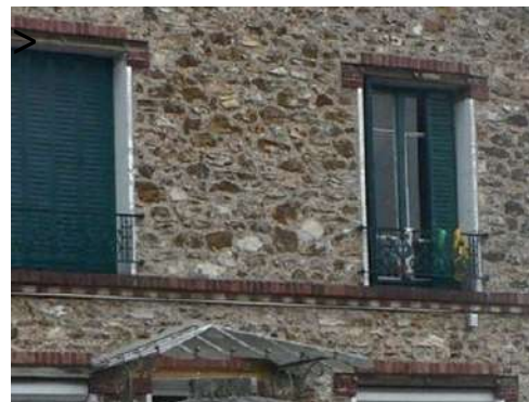
Exemple de façade en pierres meulières
