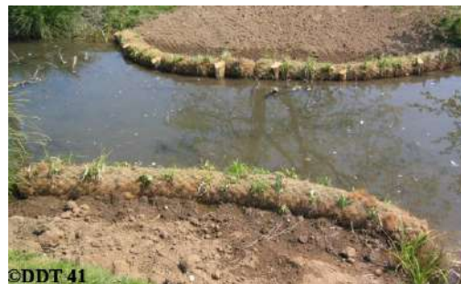
Boudins de fibre coco contenant des végétaux vivants qui vont fixer et végétaliser la berge.
