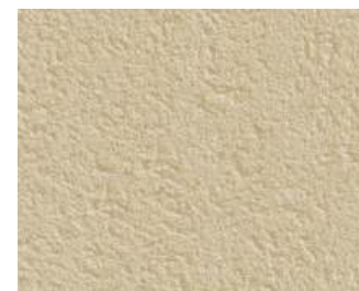
Enduit à la chaux
