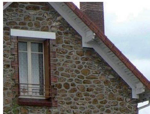
Exemple de façade en pierres meulières
