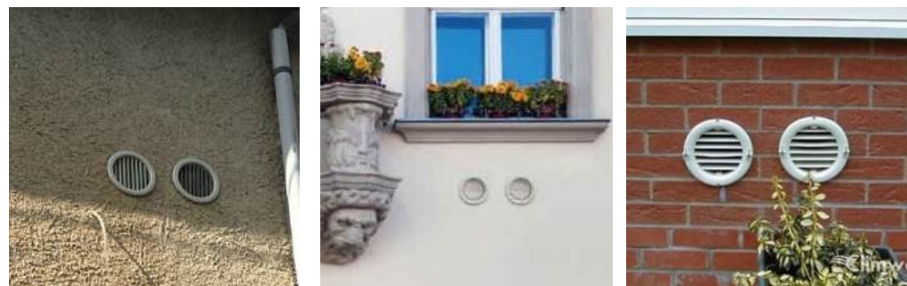
Exemples de climatisations réversibles sans groupe extérieur visible
