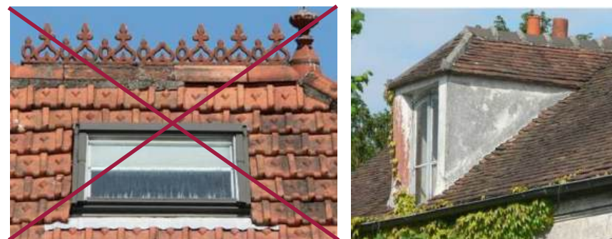
Exemples d'ouvertures assurant l'éclairage des combles
