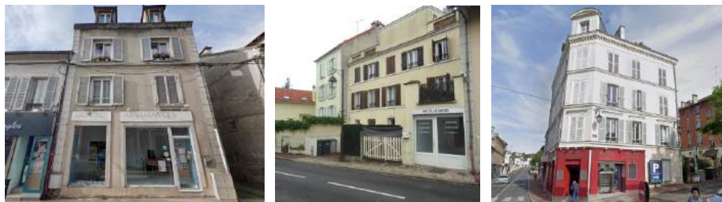
Rôle des volets battants dans l'ordonnancement de la façade
