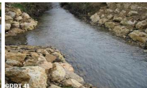
Enrochement pour limiter l'érosion d'une berge. Soumis à procédure au titre de la rubrique 3.1.4.0 de la nomenclature eau
