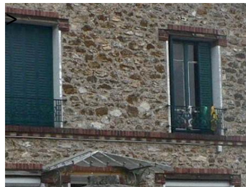
Exemple de façade en pierres meulières
