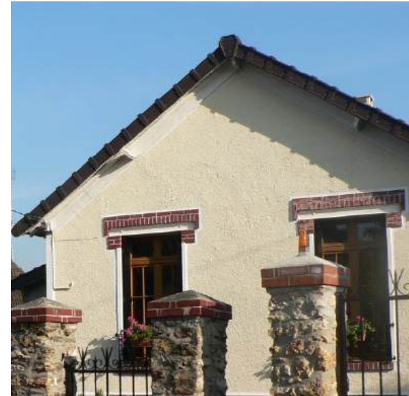
Exemple de couleur de façade
