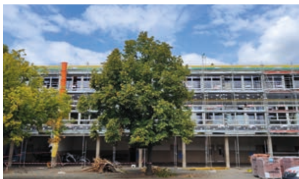
TRAVAUX D'ISOLATION EXTÉRIEURE À L'ÉCOLE DES GODEAUX
