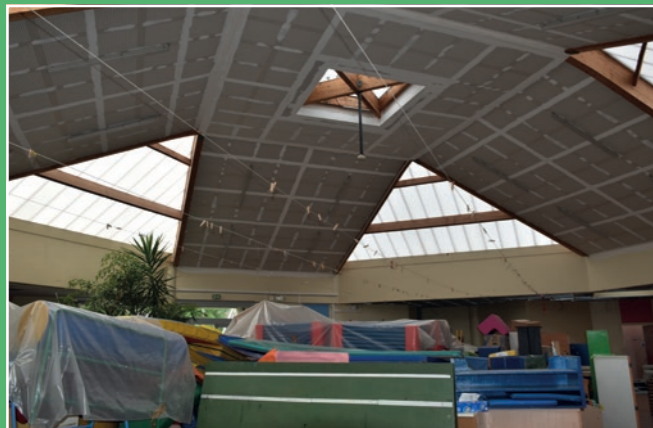
TRAVAUX D'ISOLATION INTÉRIÈRE À L'ÉCOLE MARE ARMÉE
