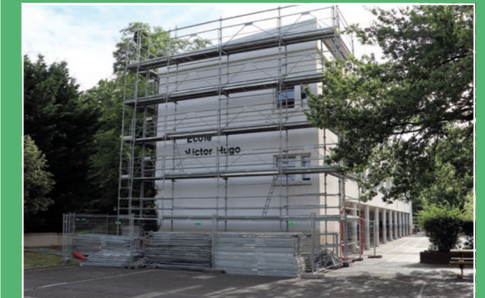
TRAVAUX D'ISOLATION EXTÉRIÈRE À L'ÉCOLE VICTOR HUGO
