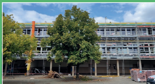
TRAVAUX D'ISOLATION EXTÉRIEURE À L'ÉCOLE DES GODEAUX (2023)
