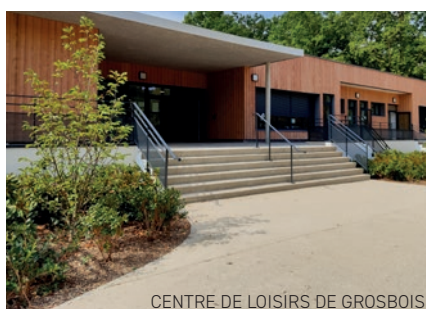
CENTRE DE LOISIRS DE GROSBOS
