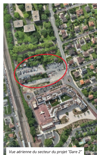
Vue aérienne du secteur du projet "Gare 2"
